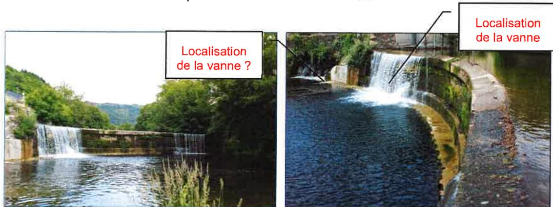
Le seuil est équipé d'une vanne de fond en rive droite de largeur 1 m et dont le radier est à la cote 506,01 mNGF.
