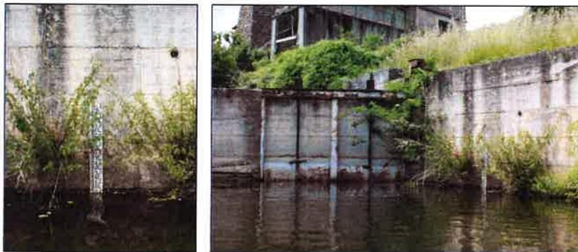
Les vannes seront reprises (décapage, traitement anticorrosion) et modernisées afin de permettre une régulation automatique de l'installation.
