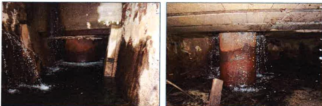
Les bassins d'aspirations sont fonctionnels mais en mauvais états. Les bassins sont partiellement comblés. Ils devront être curés, afin de restituer les capacités hydrauliques d'aspiration. Les sous-bassement et l'étanchéité des ouvrages sont à reprendre.
